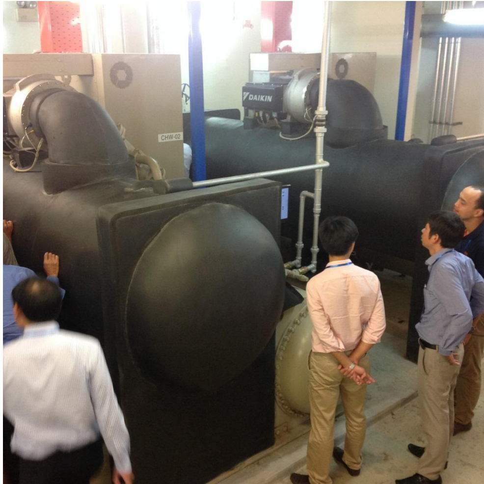
H5 - Khách hàng thăm quan chiller đệm từ của Daikin lắp đặt tại khách sạn Park Hyatt
